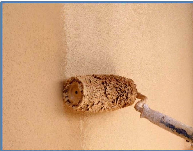
Obr. 3 - Provádění fasádního nátěru
