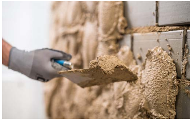
Nahazování jádrové omítky
