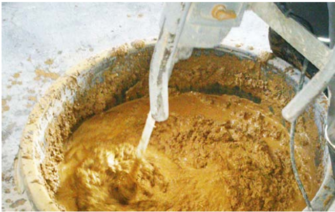
Rozmíchání omítky pomaluběžným míchadlem
