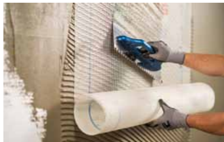
Vytváření armovací vrstvy
