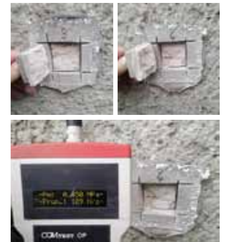
Zkouška soudržnosti k podkladu
