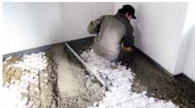
Provádění cementových potěrů
