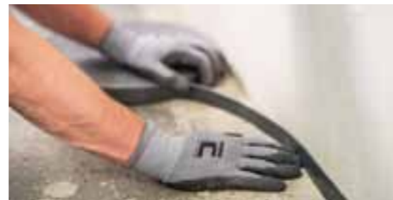
Obvodový dilatační pásek spolehlivě utěsni obvod a zajistí přerušeni akustických mostů. Umožňuje dilataci podlahy a zabraňuje vzniku prasklin ve stěrce.
