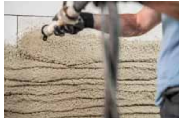
Strojní nanášení omítky
