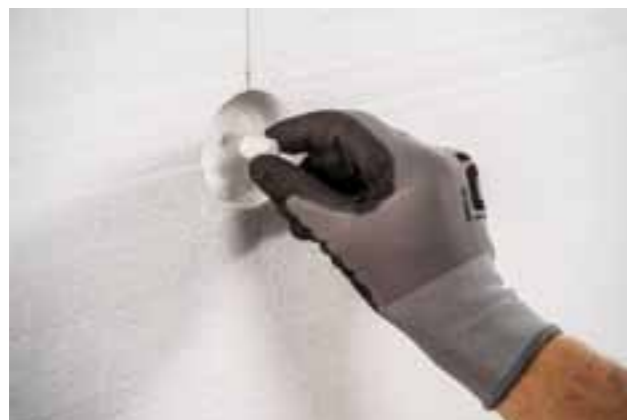
Montáž krycího izolačního víčka
