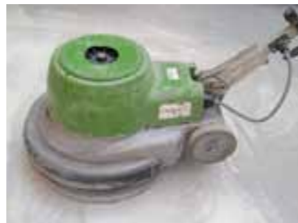
Broušení vyzrálého litého potěru
