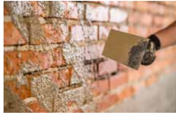
Provádění postřiku
