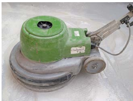
Broušení vyzrálého litého potěru
