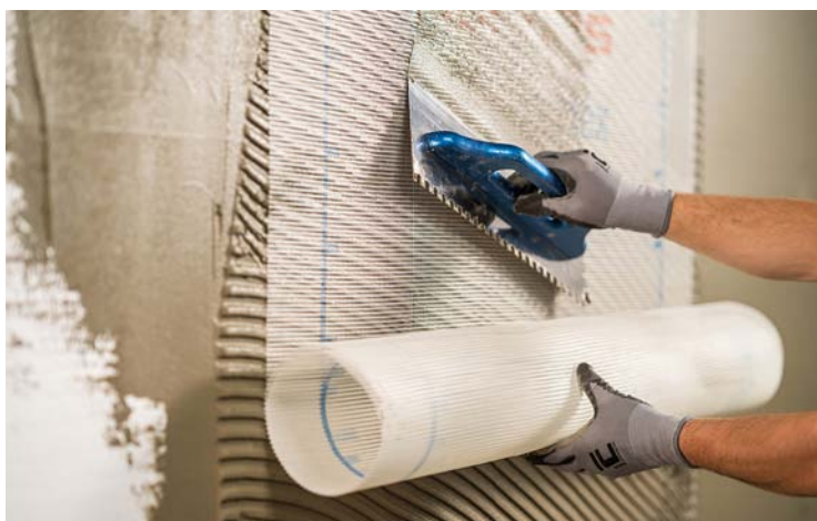
Vytváření armovací vrstvy
