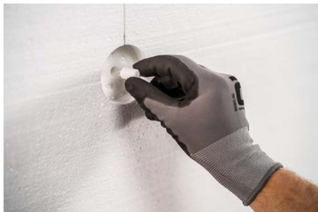
Montáž krycího izolačního víčka
