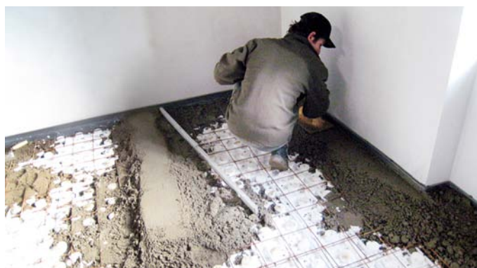
Provádění cementových potěrů
