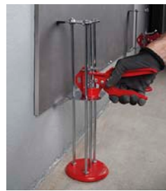
Aretace obkladu bez narušení podkladu – hydroizolační vrstvy
