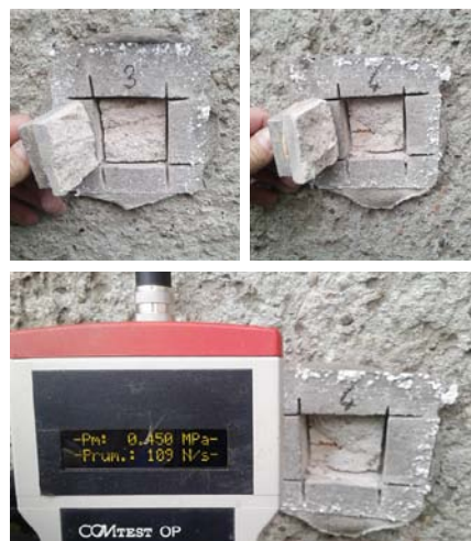
Zkouška soudržnosti k podkladu
