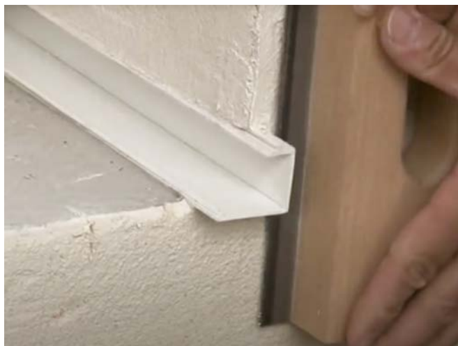
Zařiznutí přesahující části profilu SOL-PAD
