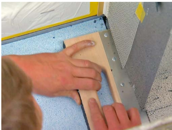
Příprava lůžka pro SOL-PAD - nařiznutí a vybrušení kapsy
