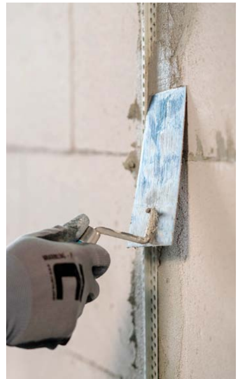
Osazení omítkového profilu
