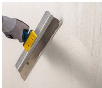
Úprava povrchu gletováním
