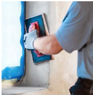
Úprava špalety po výměně okna
