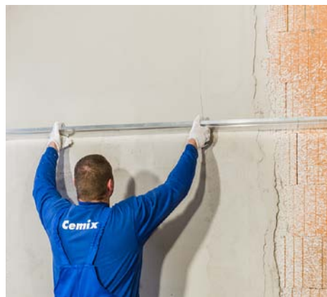
Dorovnání omítky trapézovou latí
