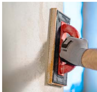
Úprava povrchu filcováním
