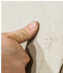
Zkouška zavadnutí omítky
