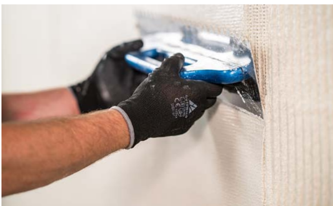
Přestěrkování povrchu Cemix 2260
