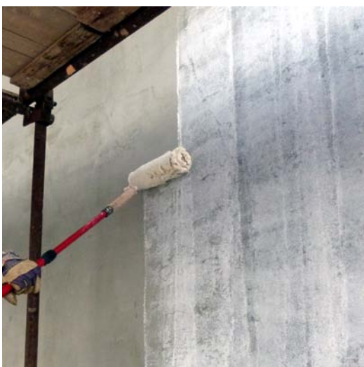
Úprava podkladu penetračním nátěrem
